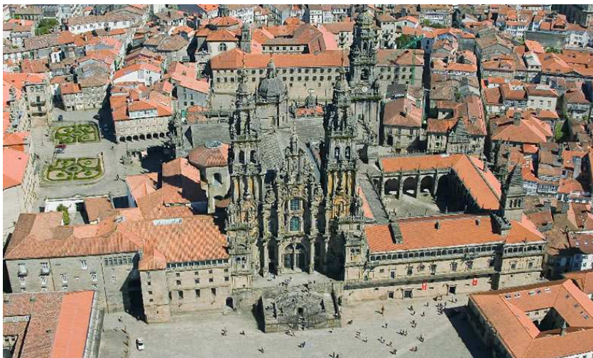
Fotografía aérea de la plaza del Obradoiro / Janet González Valdés
